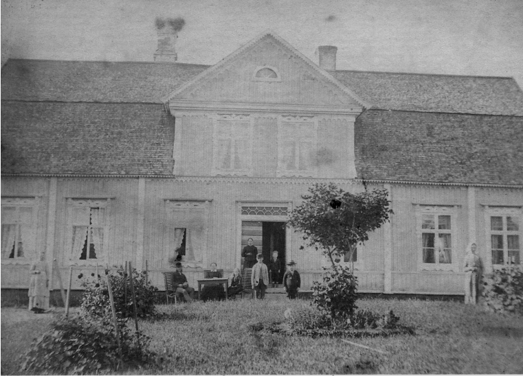
Johan Jönssons gård i Tararp. Mangårdsbyggnaden, före branden.
