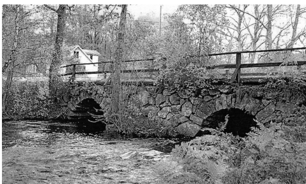
Den gamla bron. Foto Stig Torstensson.
